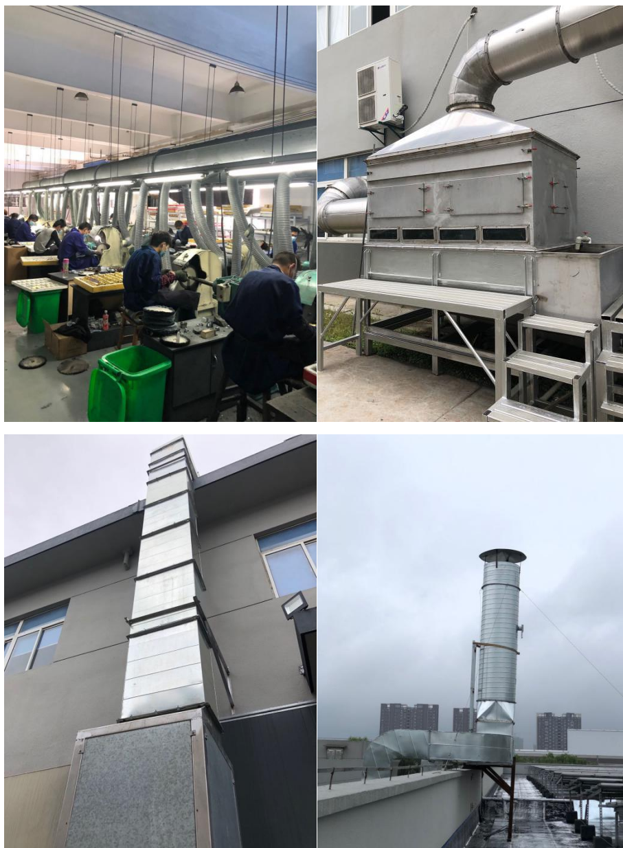
图 4-3 抛光粉尘治理设施现场照片
